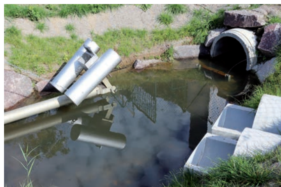
Station de traitement des eaux pluviales
